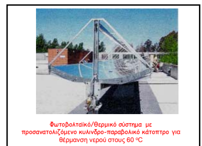
Φωτοβολταϊκό/θερμικό σύστημα με συμμετρικό κάτοπτρο CPC για θέρμανση νερού μέχρι 60 °C ARONTIS
